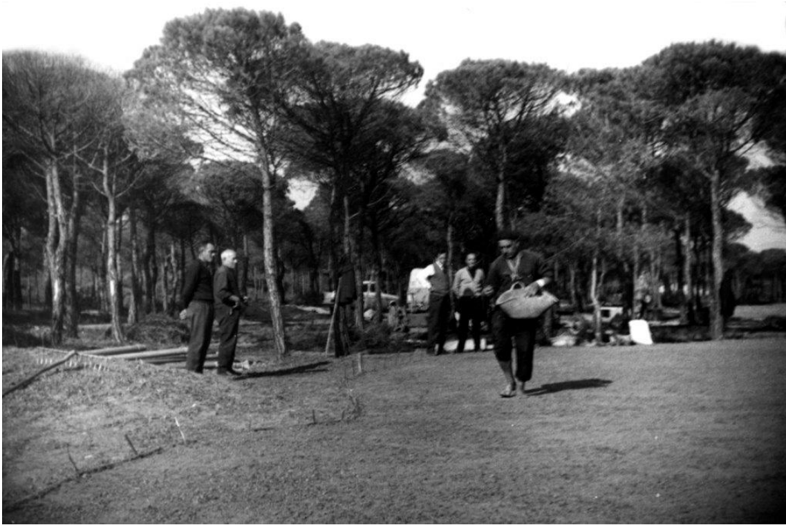
Golf de Pals construction
