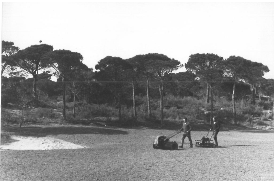
Golf de Pals construction
