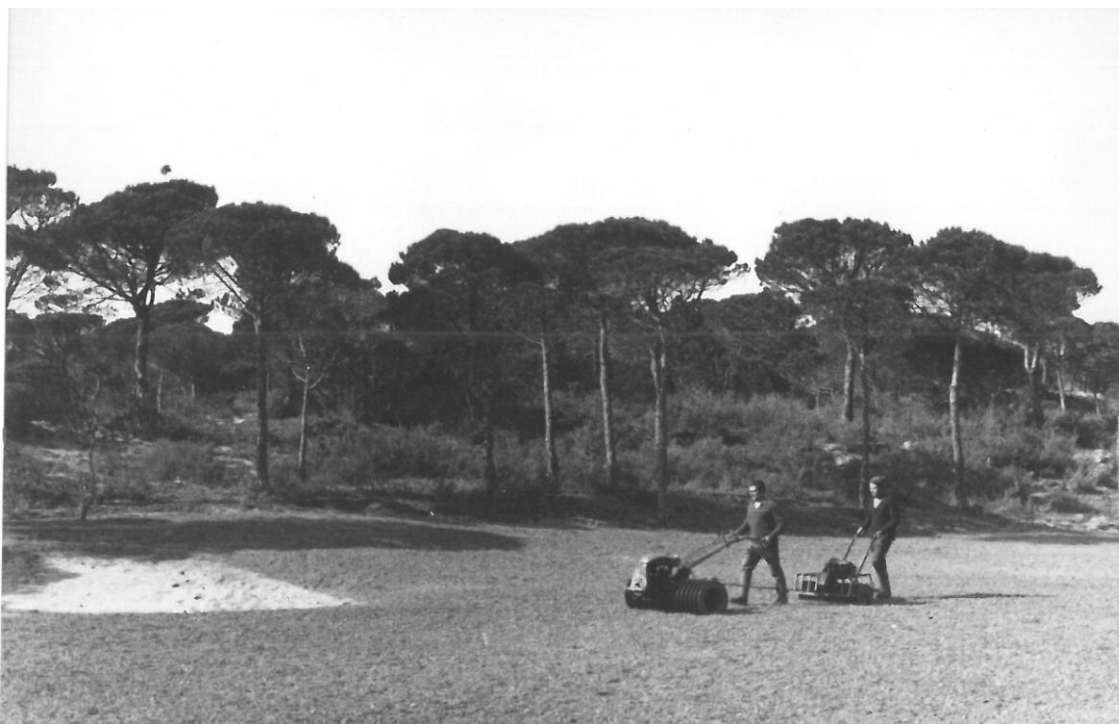
Construcción Golf de Pals
