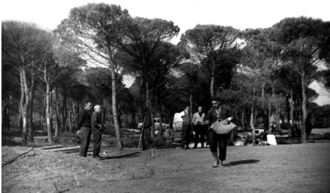
Construcción Golf de Pals
