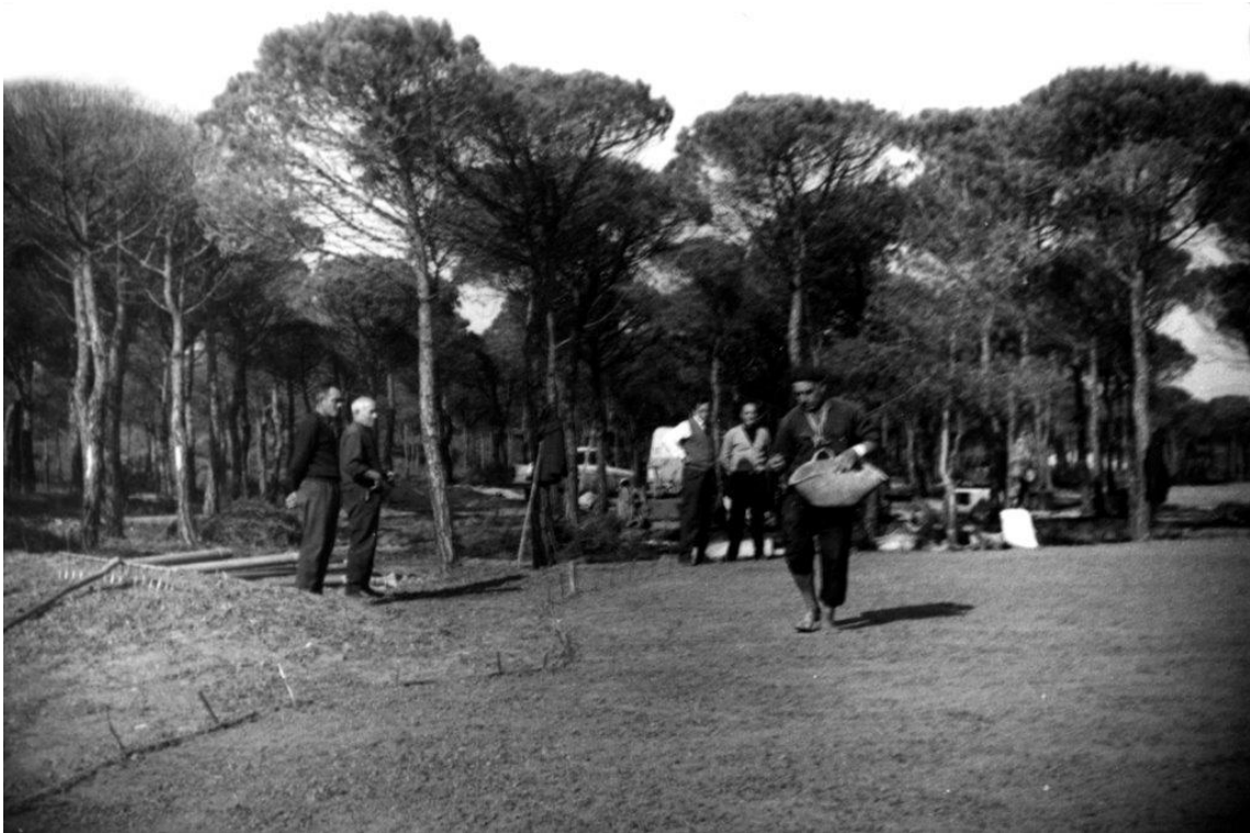
Construcción Golf de Pals
